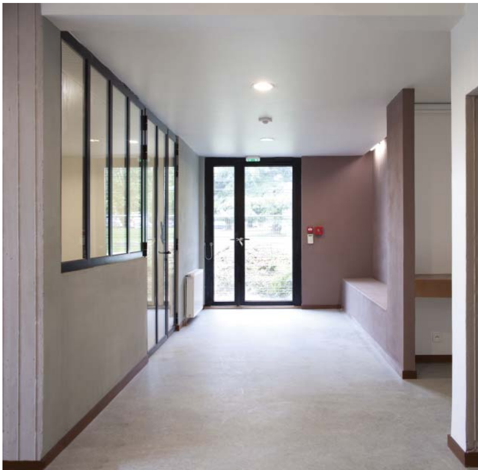
Hall d'entrée et salle de réunion à droite. Banquettes en béton cellulaire enduit
