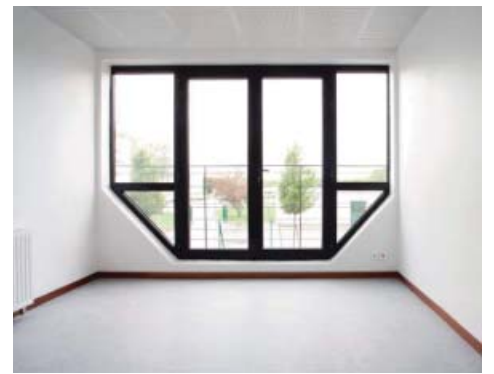
Nouvelle baie vitrée acier à l'emplacement des loggias
