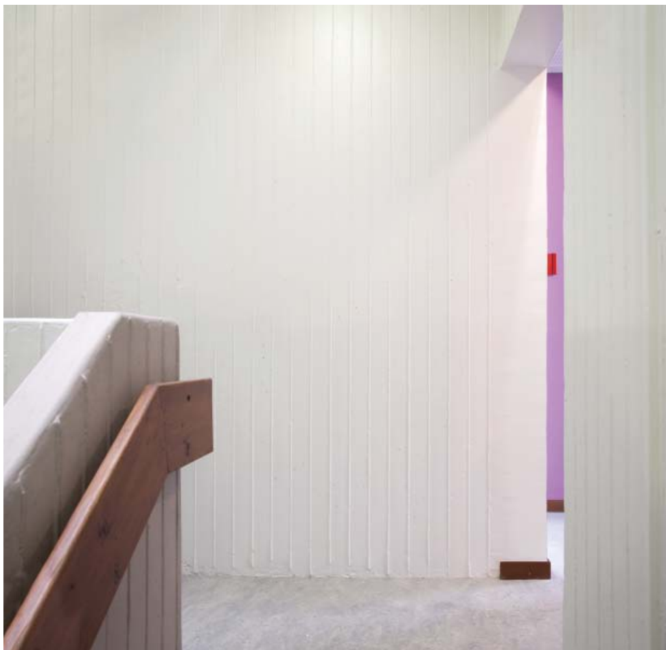
Béton rainuré d'origine
