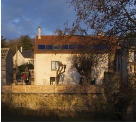
Côté jardin, enduit à la chaux au sable de région. Les panneaux solaires en toiture permettent d'assurer les besoins en ECS et une partie des besoins en chauffage
